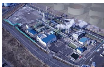
CO2分離・回収・貯留施設
