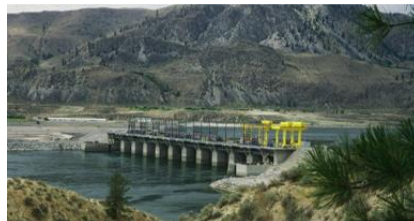
水力による水素製造施設
